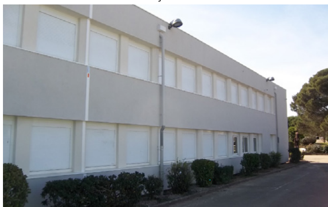
Isolation thermique du bâtiment externat du collège Gaston Bonheur
