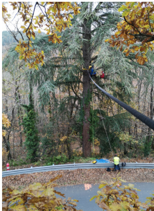
Installation de l'écuroduc au dessus de la RD118 à Cuxac-Cabardès
