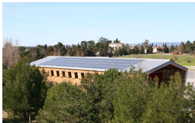
CAUE, 170 m 2 de panneaux photovoltaïques posés en toiture
