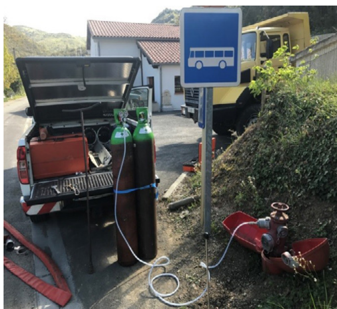
Recherche de fuite par injection de gaz
